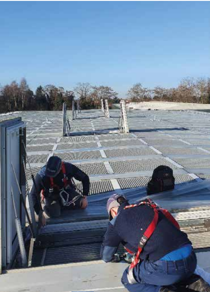
Des travaux de maintenance des exutoires en toiture ont pu être effectués.
