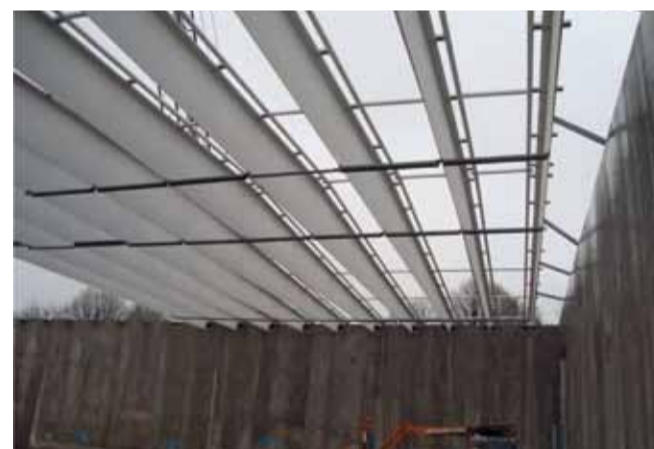
© CR La pose des poutres de la Galerie du temps
