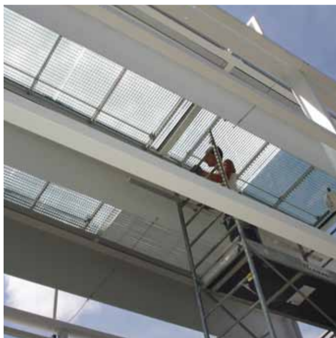
© CR Le prototype : test du dispositif d'occultation sur le toit
