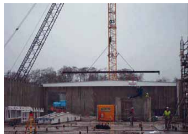
© CR La pose des poutres de la Galerie du temps
