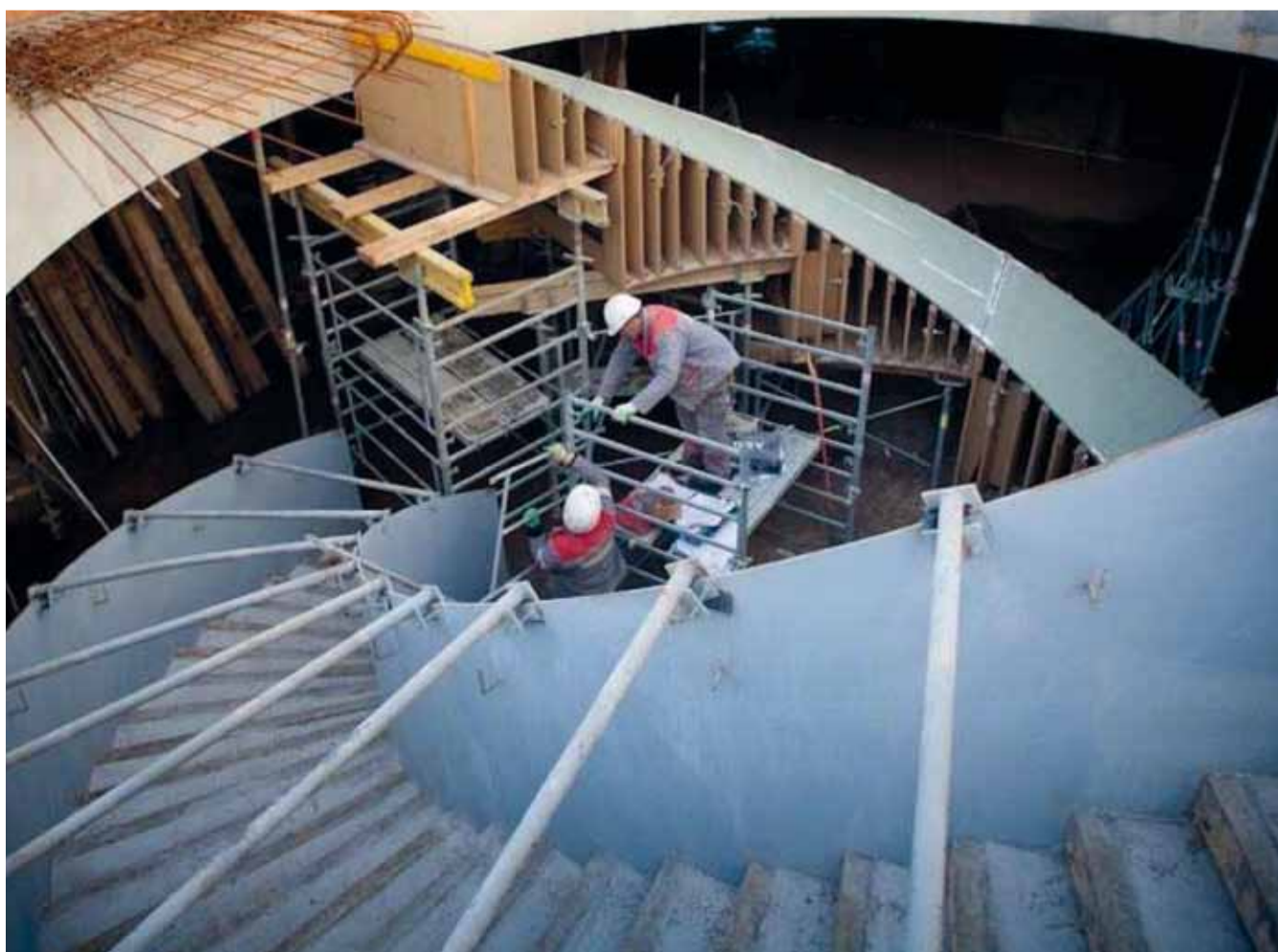
© CR L'escalier destiné à l'accueil des groupes
